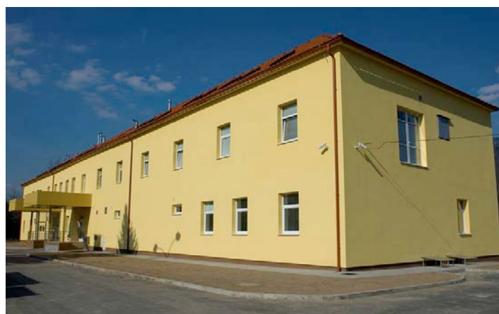
Zrekonštruovaná budova Konzervačného a digitalizačného centra vo Vrútkach
